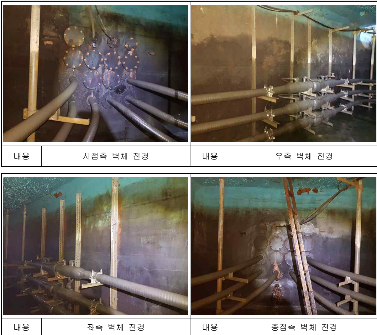
【사진 11.17】 신평주~송포 #5 전경
